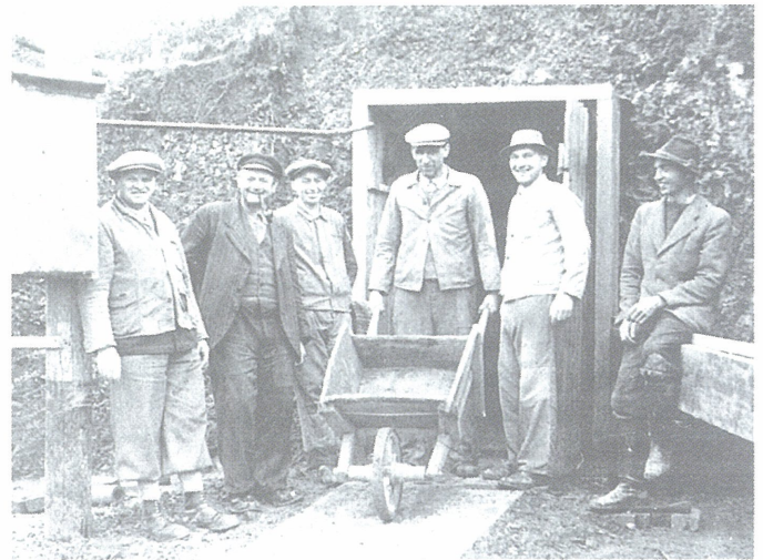
Stollenbau im Bereich der Nöllenstraße
