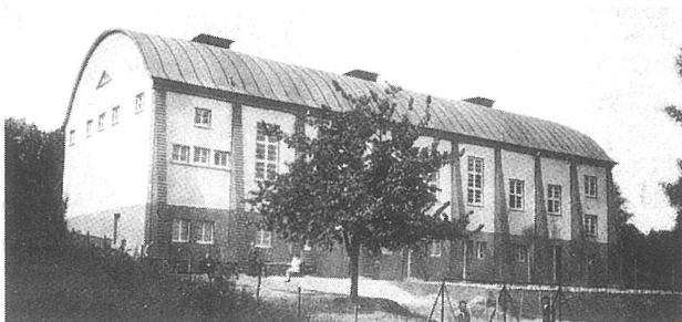
Die »alte« Liederkranzhalle, auch sie brannte bis auf die Grundmauern ab.
