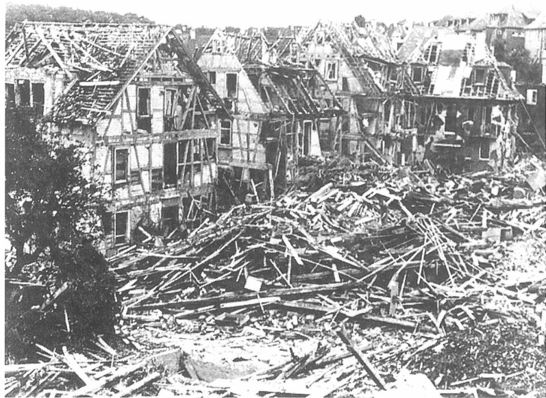
Trümmer über Trümmer im Bereich Haydnstraße/Fleckenwaldweg
