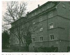
Die Gebäude an der Beethovenstraße werden bis April kommenden Jahres als Notunterkunft genutzt.
