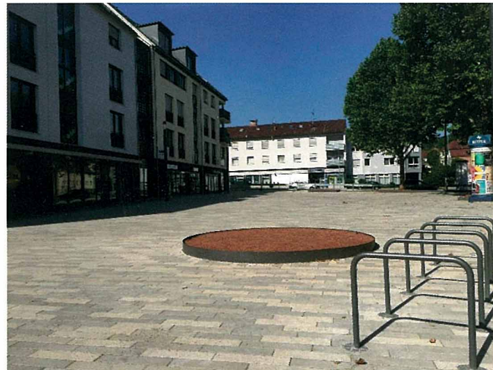
Der Marktplatz mit dem „Botnanger Parkett“ (Landschaftsarchitekt Koeber) im Juli 2017. Es fehlen noch zwei Bäume, Brunnen und Möblierung. Linker Hand die Neubauten mit Discounter, Ladeneinheiten, Kaffee und dem neuen städtischen Kindergarten.
