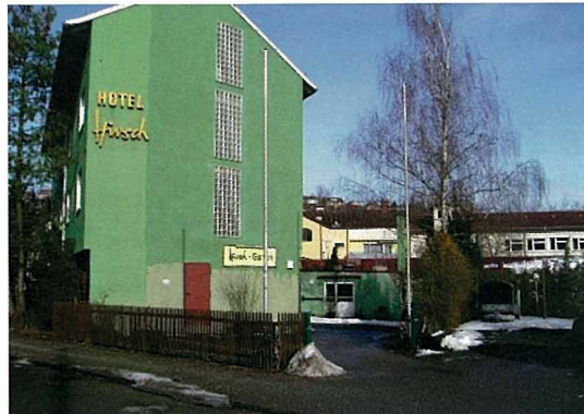
Das Hotel Hirsch vor dem Abbruch mit markantem Schriftzug, Rechts Teile der jahrelangen Brachfläche
